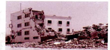
c - Séisme d'Agadir 29 février 1960 causant la mort de plus de 12 000 personnes.
